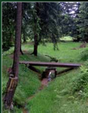
6. Blatenský příkop | Plattener Wassergraben | Horní Blatná Water Channel
