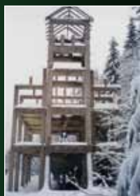
2. Hlavní šachta | Hauptschacht | Main Shaft
